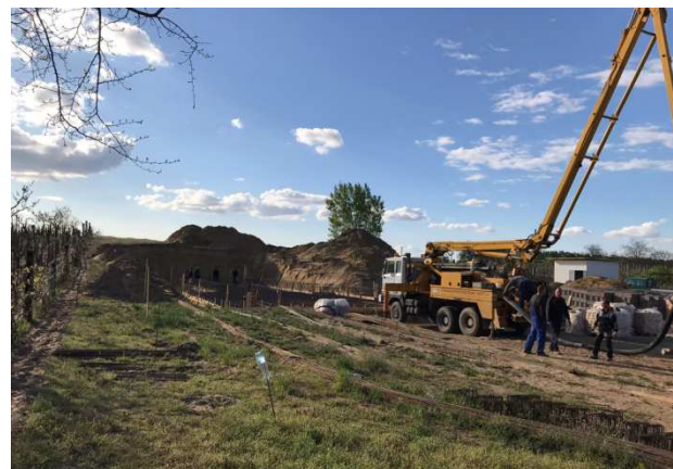
Az épülő présház
