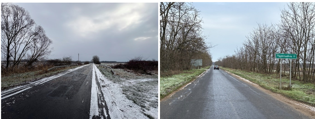
a Cserei csatorna és az országos mellékút keresztezése és az útfelújítási beruházás vége
