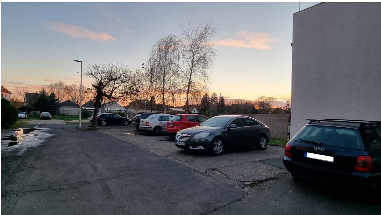
A 12084/1. hrsz-ú ingatlanon található út és parkoló területek. Forrás: Saját fotó
