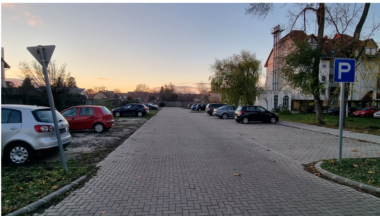
A 12084/1 hrsz.-ú és 12083/2 hrsz.-ú ingatlanon található út és parkolók, valamint tervezett parkoló helye. Forrás: Saját fotó
